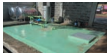
排水処理施設の様子
