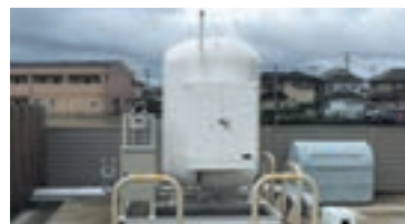
災害対応バルク貯槽システム
