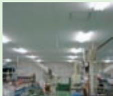
牧之原工場・鷺津分工場（静岡県湖西市）では、老朽化した組立工程の照明器具 179 台を、更新時に省エネルギー効果の高いインバータータイプの照明器具に変更しました。
