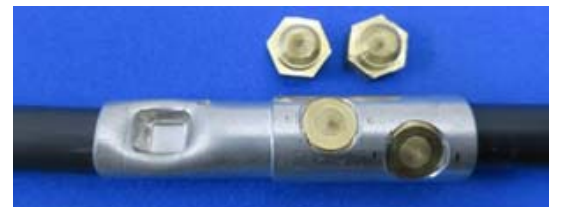
【接続作業完了】
