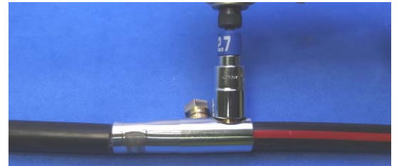
【インパクト・ドライバーによる接続作業】
