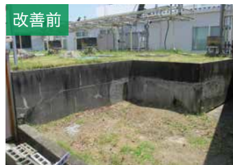
改善前 埋設された廃液貯槽 (漏えいの目視確認が困難)
