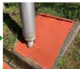
(改善後) 配管外に吸音・遮音材を設置 また、騒音発生部にカバーを設置
