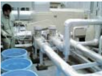
吸収溶液の回収作業
