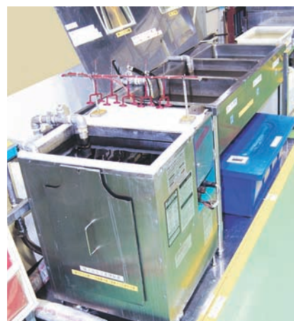
榛原工場のアルカリ洗浄液浄化循環装置
