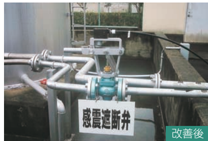
灯油タンク配管に感震遮断弁を設置(大東工場)
