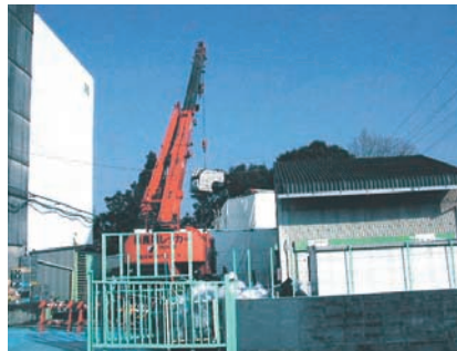
榛原工場の焼却炉撤去作業
