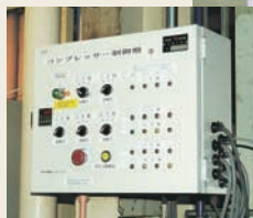
コンプレッサー制御盤
