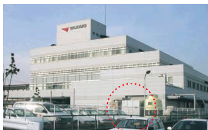
中部カスタマーズセンターのコージェネレーションシステム
