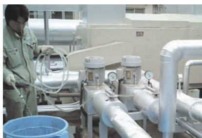
吸収溶液の抜き取り作業
