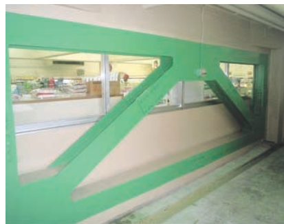
事業所の補強工事例
