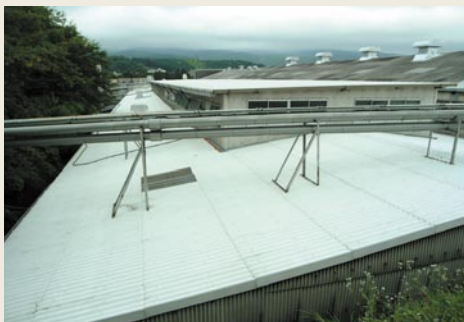
断熱塗装を施した屋根
