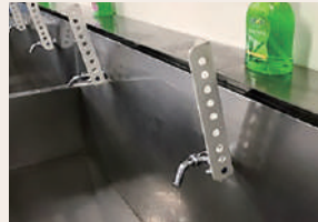
【ミャンマー】 手でひねらずに使用可能な蛇口へ改良
