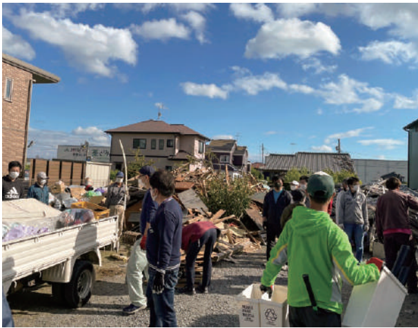
復旧作業の様子
