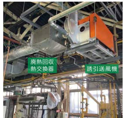
廃熱回収熱交換器
