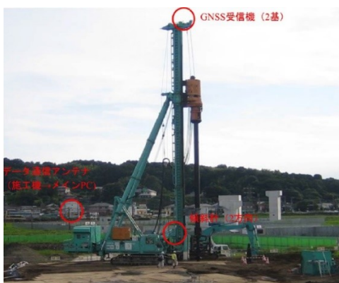
写真-1 施工状況
