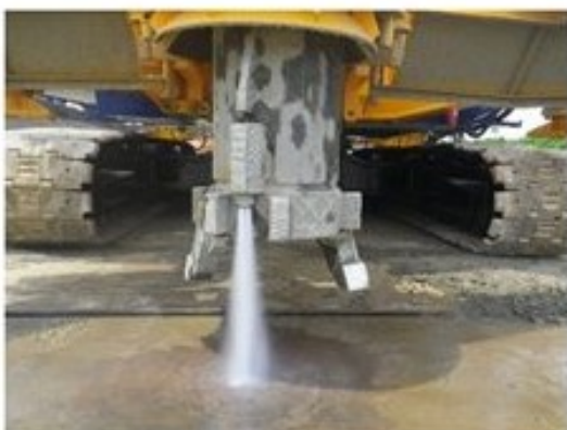
写真-3 貫入補助エジェクター吐出状況
