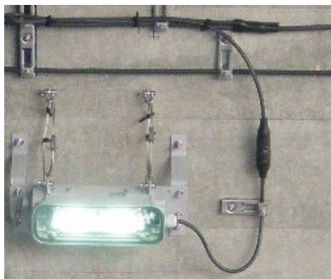
写真-5 中間接続型設置状況
