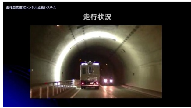
写真-2 走行状況
