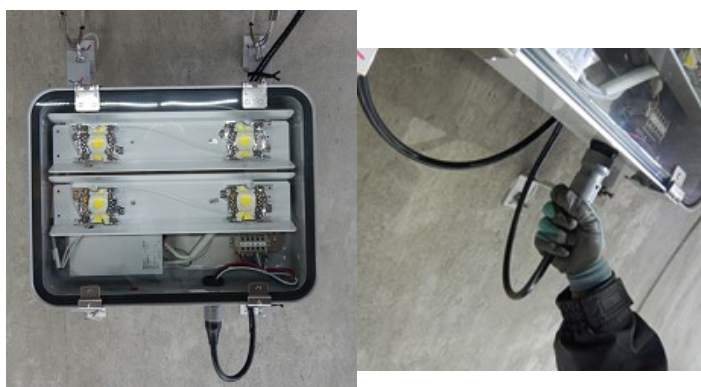
写真-6 照明器具直結型施工状況
