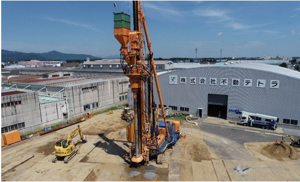
写真-1 SAVEコンポーザーHA 施工状況
