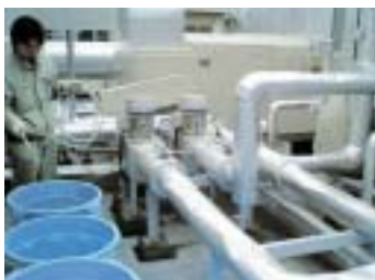
吸収溶液の回収作業
