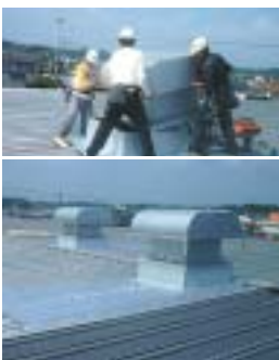
屋上に設置したルーフファン
