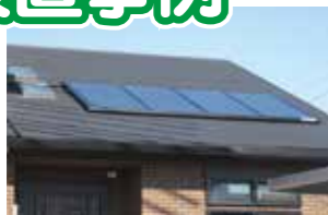
スレート屋根 - ラック施工 【ESC-T1020J×4枚 / 全周カバー】
