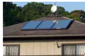
スレート屋根 - 固定線施工 【ESC-T1020J×3枚】
