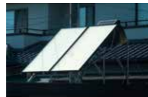
陸屋根 - 架台施工 【SP-W420T】
