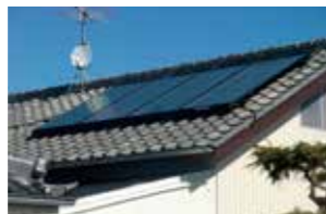
日本瓦 - 固定線施工 【ESC-T1020J×4枚】
