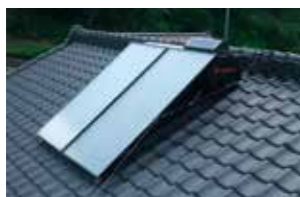
日本瓦 - 固定線施工 【SP-W420T】
