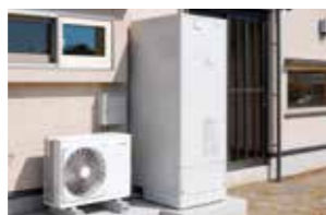
貯湯槽 - エコキュート・ソーラーヒート 【貯湯槽 420ℓ + ヒートポンプ】
